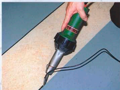
Сварочный аппарат ТРИАК S с насадкой быстрой сварки
