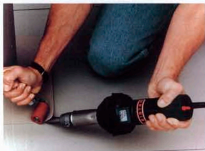
Аппарат ТРИАК PID с щелевой насадкой 20 мм и прикаточный ролик при сварке кровельного покрытия из ТПО.
